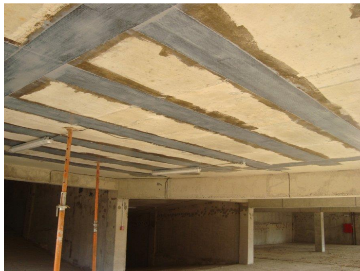
Рисунок 3 – Общий вид монтажных швов, оклеенных стеклотканью в три слоя (ТОО «СейсмоСтройПроект»)
